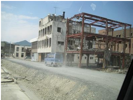
▲女川はガレキ撤去と道路かさ上げ中
